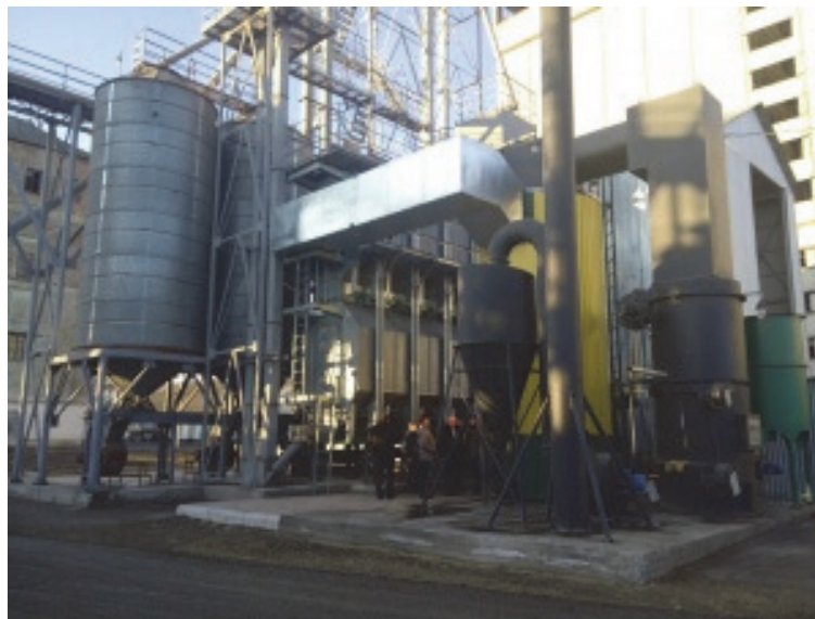
Рис. 1. Комплекс на базі зерносушарки Sukup і біотеплогенератора
