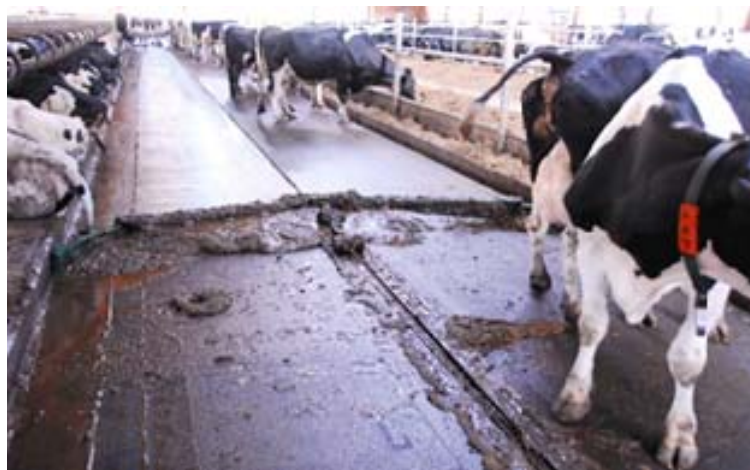
Рис. 1. Гладка бетонна поверхня гнойового каналу.
