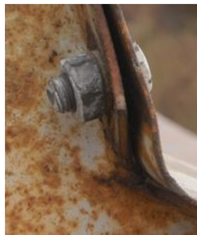
Рис. 6. Послаблення болтового з'єднання.
