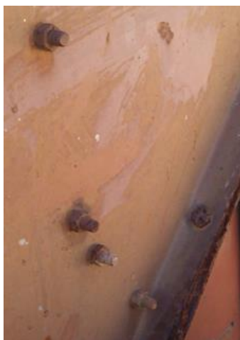
Рис. 5. Вихід стрижня болта за межі гайки (не відповідає нормованим вимогам).
