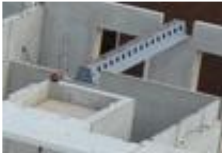
Рис. 1. Установка сталебетонної балки в крупнопанельній будівлі з подальшим монтажем на балку порожнистих плит [1].
