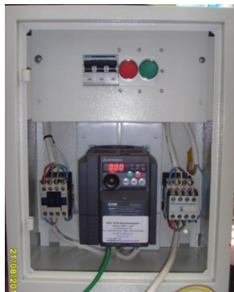
Рис. 8. Частотний перетворювач Mitsubishi FR-D740 для керування рухом скребкового конвеєра.
