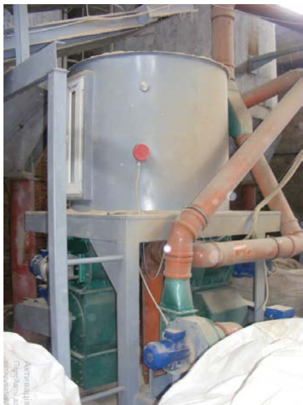
Рис. 4. Накопичувальні бункери сировини після попереднього дроблення.
